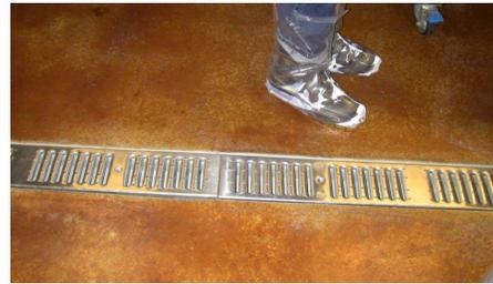
*Este es un sistema eficaz de drenaje por canaletas, instalado en un área de procesamiento de alimentos.*
