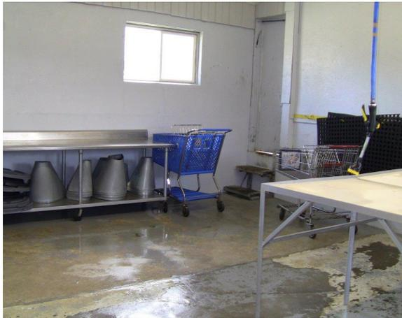
*En un piso desnivelado (p. ej., con uniones y parches) o con poca pendiente, se pueden acumular agua y basura, lo que dificulta y retrasa el mantenimiento de las condiciones higiénicas.*
